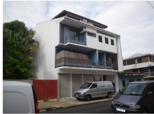
Façade sur la rue Becker, avec l'ajout de 2 climatisations aux derniers étages
