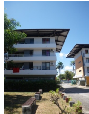
Présence de split au 1 er et 2 e étage
