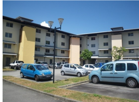
Faible aménagement de la zone de parking
