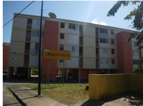
Façade Ouest sans protections solaire
