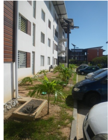
Espace végétalisé en périphérie du bâtiment et manque de protections solaire
