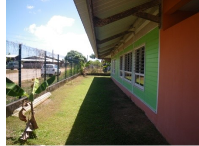
Large débord de toiture apportant une protection sur toute la hauteur du bâtiment
