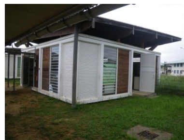
Parois au vent très poreuses mais peu protégées
