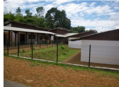
Terrain déblayé pour la construction.
