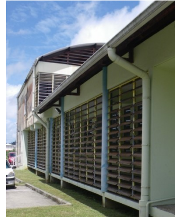
Brise-soleil verticaux à lame de bois sur les parois
