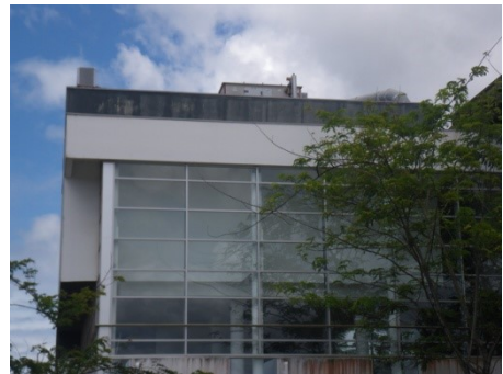
Grande façade vitrée peu protégée au Nord-Ouest donnant sur l'atrium climatisé
