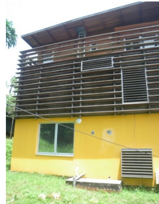
Protections solaires en façade
