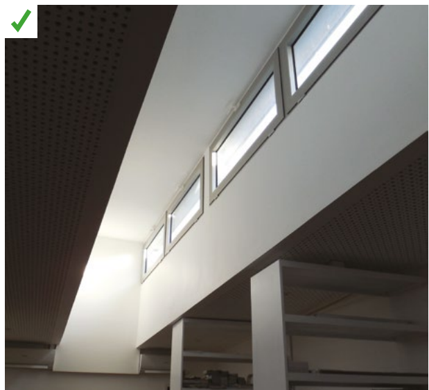
Puits de lumière orienté Ouest captant le soleil d'après-midi et de fin de journée, limitant l'usage d'éclairage électrique. Associé à une ventilation naturelle efficace, il apporte un confort visuel très important aux usagers, sans occasionner de surchauffe. ©AQC
