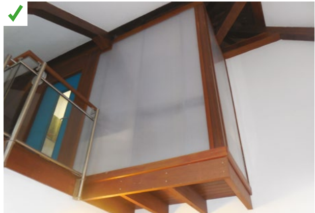
Paroi translucide installée lors de la réhabilitation favorisant l'éclairage naturel la pièce. ©AQC
