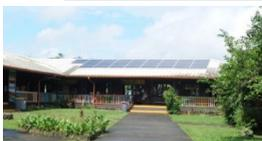
« Dans le cadre de sa convention TEPCV, le PNRG a pu équiper l'école élémentaire de Cacao avec un générateur photovoltaïque de 10 kWc, raccordé en autoconsommation et sans stockage » (Source INGEKO).
