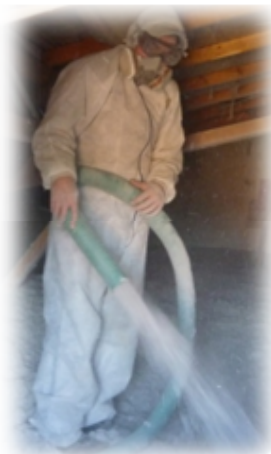
Stockage de matière première (papiers, journaux...) (Source photos : IGLOO France) Soufflage ouate en vrac
