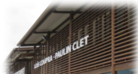
Brise-soleils verticaux, maison des entreprises. Sinnamarv (photo : D. Gibert)
