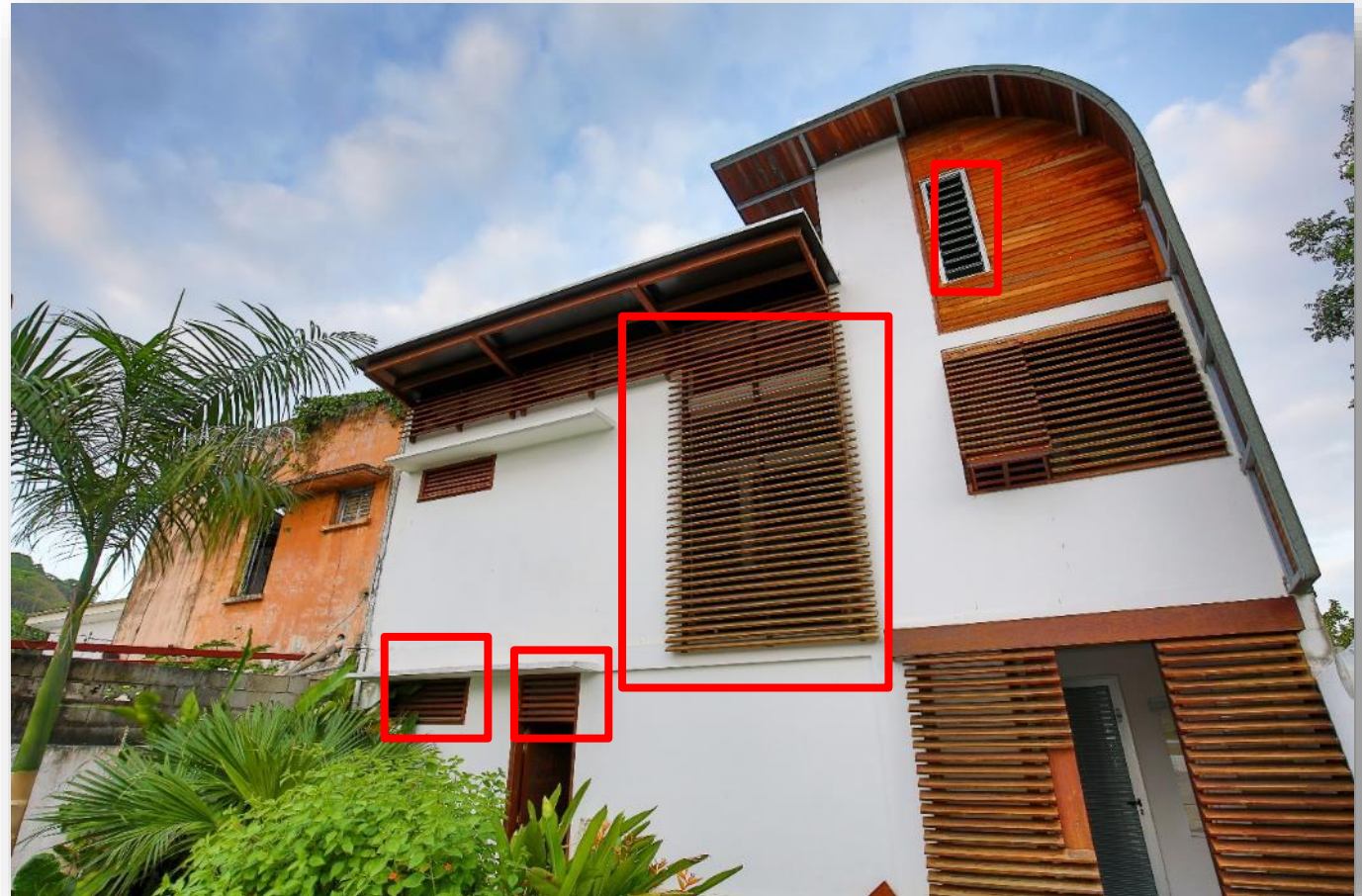
Réhabilitation-extension. Architecte Atelier C-M.GADRET
