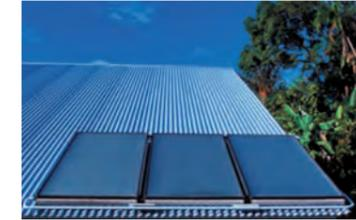
Même en saison des pluies un chauffe-eau est efficace car il y a toujours du rayonnement solaire diffus qui traverse les nuages pour chauffer l'eau. De plus, un ballon de stockage permet de conserver l'eau chaude pendant plusieurs jours. Un appoint électrique est généralement inutile.
